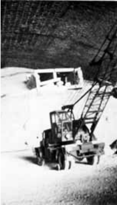
1959 Die Stelle im Bunker, an dem die Bomben gesprengt wurden. Die Explosionen lösten 1 m der 3 m dicken Betondecke ab. Man erkennt das Eisengeflecht der Betonarmierung. Der Kiesentnahmetunnel, durch den der Kies aus der Bunkerschale gebracht wurde, ist verschoben und die Wände durch Bombensplinter vernarbt. Diese Sprengungen veranlassten die Bevölkerung, an Sprengversuche der Amerikaner zu glauben, um den Bunker zu zerstören, wie es in Mühlendorf geschah. Quelle: Bunkersammlung Luftwaffe
