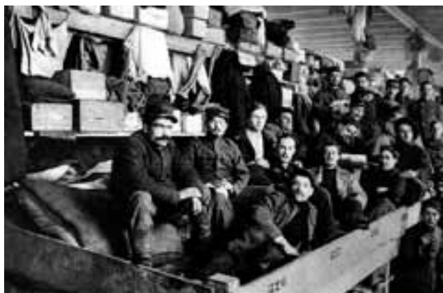
Schlafkojen in der oberen Etage. Dahinter die Regale mit den persönlichen Habseligkeiten der Franzosen.
