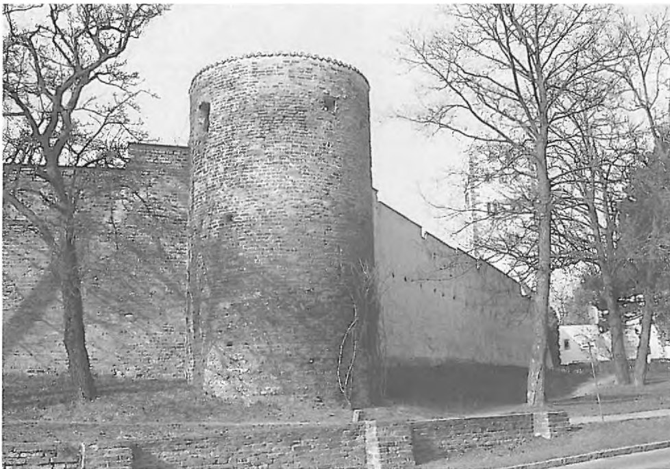
Abb. 3: »Kleiner Pulverturm« (T 22)
