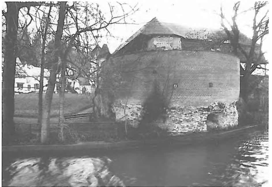
Abb. 20: Färberturm (T 41), Stumpf mit Schießscharten u. Aufmauerungen v. 1970
