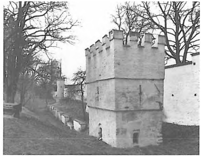
Abb. 10: Ostmauer, im 19. Jh. aufgebauter Zwingerturm zwischen T 24 u. T 25
