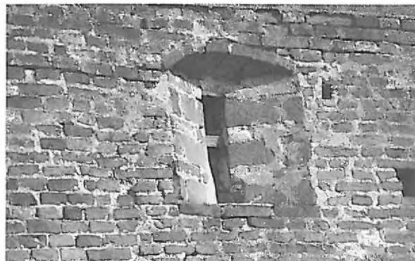
Abb. 14: Schlitz mit Prellholz
