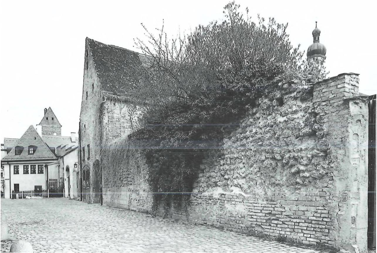
Abb. 3: Erste Stadtmauer in der Hinteren Salzgasse, gemauert aus Nagelfluhbrocken.
