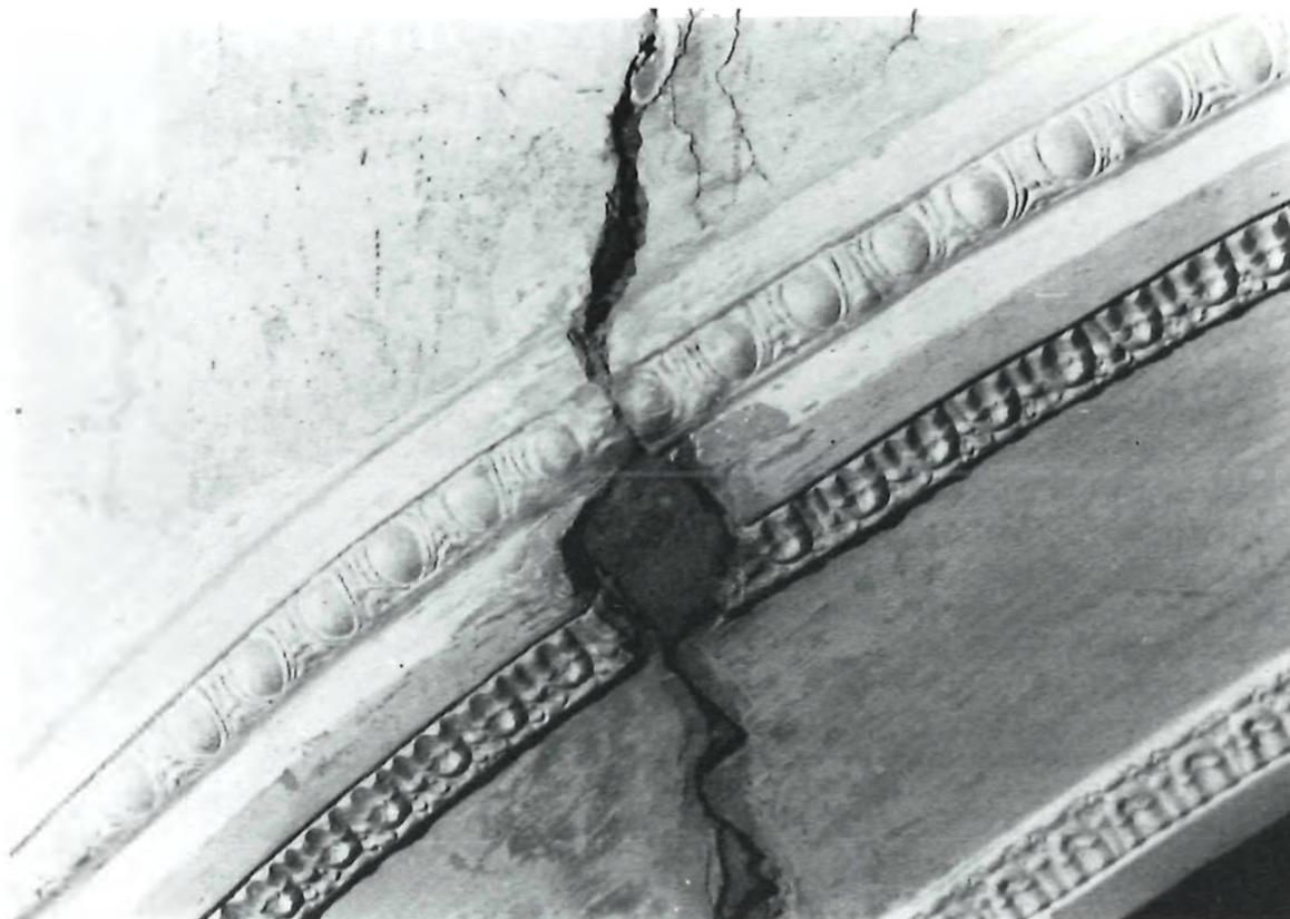
*Oben: Versetzungsriß am Gurtbogen zwischen Emporendecke und Gewölbe des rechten Seitenschiffs. – S. 55: Wieder freigelegtes Barockfresko am Chorgewölbe*
